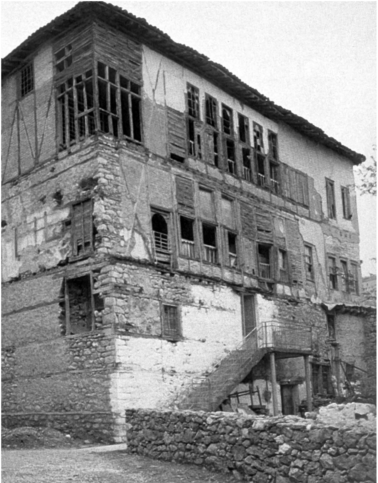
πιν. 82: Ενδεικτική φωτογραφία με λήψη υπό γωνία, προκειμένου να επιτευχθεί η τρισδιάστατη τεκμηρίωση του αντικειμένου. Οι φωτογραφίες αυτού του τύπου ενδείκνυνται για την τεκμηρίωση του όγκου του κτιρίου, καθώς και για την κατασκευή τρισδιάστατων μοντέλων. Λόγω της πλάγιας λήψης των όψεων, δεν ενδείκνυνται για αναγωγή και εξαγωγή ακριβών μετρητικών στοιχείων
